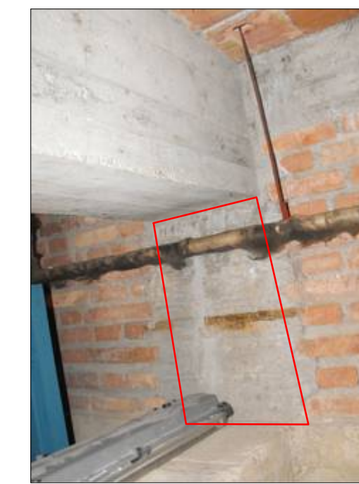
Particolare pilastri tozzi Lato Sud - Ovest
