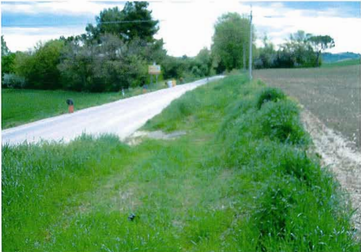
Fotografia n.9 – Variante (6) Via delle Selve – Particolare zona a monte della futura rotatoria
