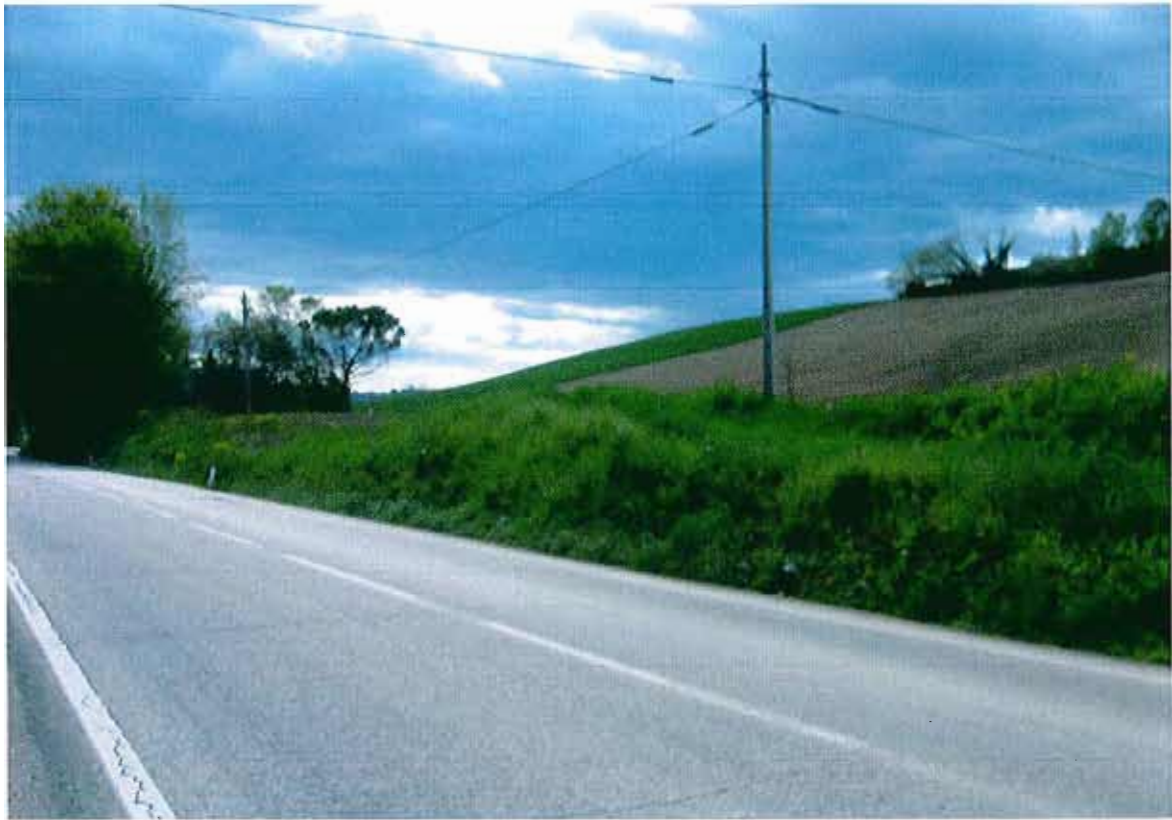
Fotografia n.7 – Variante (6) Via delle Selve – Panoramica versante a monte area rotatoria
