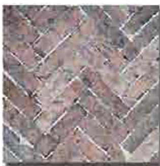
pavimentazione in cotto disposto a spina di pesce (C)
