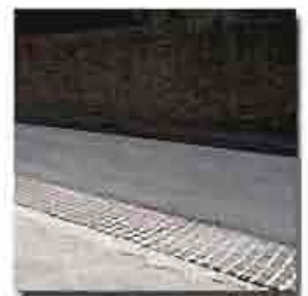
asfalto con cunette laterali in porfido
